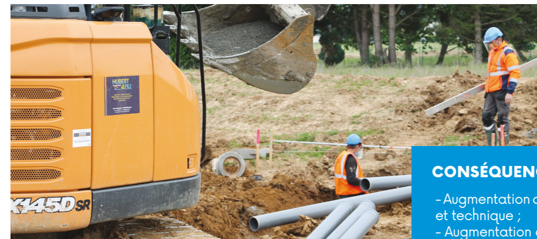
Reprise des chantiers « La Borde » à Notre-Dame-d'Oë
