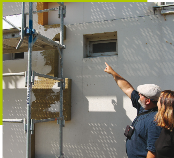
Chantier « Levée de la Loire » à La Riche
